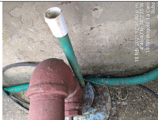
Foto No. 5. Boca del pozo
