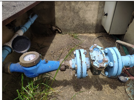
Foto No. 3. Visita general del pozo
